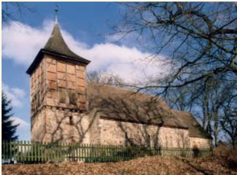
Feldsteinkirche in Kölnow
